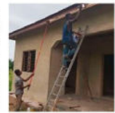
Malerarbeiten werden am neuen Gebäude vorgenommen. Foto: Friends without borders
