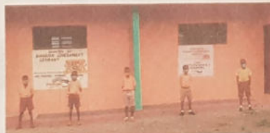
Jeweils drei Toiletten für Mädchen, drei für Jungs – die beiden Sanitäreinrichtungen in Mafi Dadoboe sind fertig. Foto: privat
