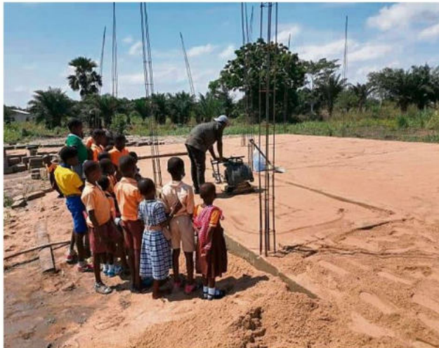
Auf dem Foto zu sehen: Der Rüttler zum Verdichten des Bodens macht die Kinder neugierig.
